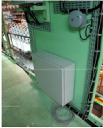
Bộ thu thập dữ liệu (PMI-DAU) lắp đặt trong buồng máy
